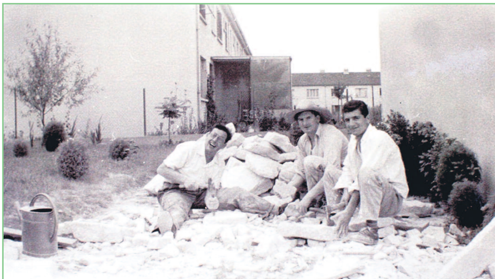
Les voies d'accès, les espaces verts et les murets des jardins de la résidence ont été réalisés le week-end par "les castors", les futurs habitants du quartier.
